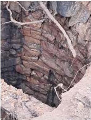
Inquiets, ils mesurent la profondeur du trou : 1 m, 2 m, 3m! Un entrepreneur appelé s'aperçoit qu'il s'agit d'un puits maçonné dont l'orifice avait été obturé par un couvercle de bois, le tout recouvert de terre il y a des décennies. Le bois entièrement pourri avait fini par tomber dans le puits sous le poids de la terre.
