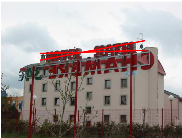
Enseigne sur toiture à proscrire
