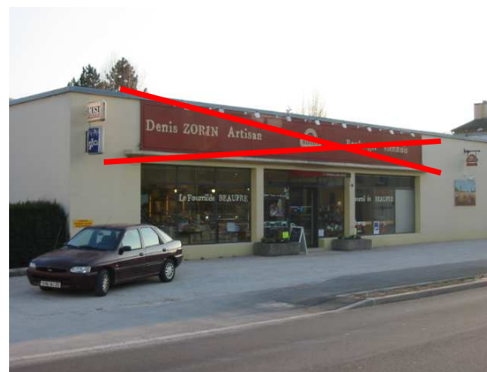
Enseigne en bandeau > 8 m 2 et >15 % de la façade
