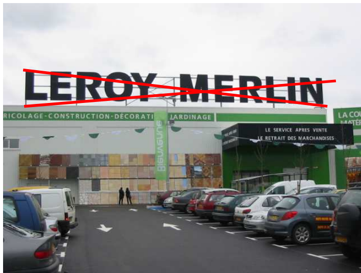
Enseigne sur toiture à proscrire
