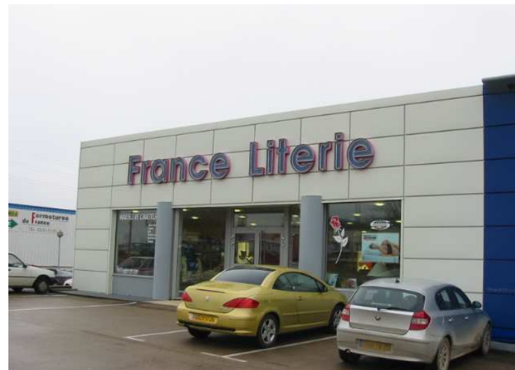
Enseigne sur façade autorisée
