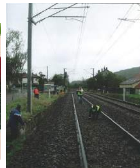
Nettoyage des voies
