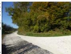
La rue des Boillons, entre le bois de la Vaivre et une frênaie, et sur une longueur de 250 m a elle aussi été entièrement refaite : reprofilage, encaissement, double couche d'émulsion et gravillonnage. Elle en avait grand besoin car le passage de poids lourds, sa déclivité entraînant des ruissellements d'eau etc. l'avaient fortement endommagée.
