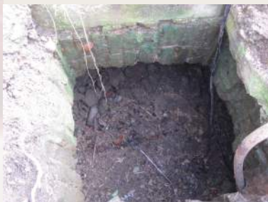
Puits d'accès fonctionnel
