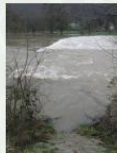
L'eau a submergé la culée du barrage
